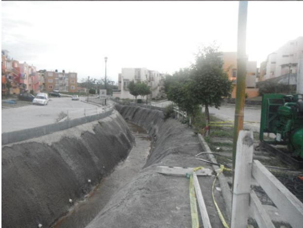
Figuras 6 y 7. Vía colectora, y canal de agua pluvial. Fuente: Elaboración propia.
